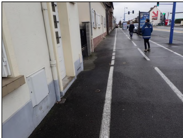
Figure 41 : Tronçon 3 bis : bâtiment encastrés sur les deux talus (source : Rapport VTA, 2020, ISL)
