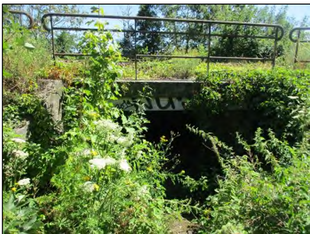
Figure 38 : Tronçon N°3 : côté Oise, entrée du passage sous voirie SNCF (source : Artelia)
