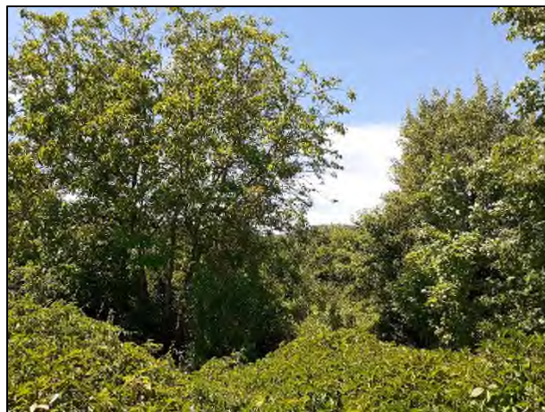
Figure 37 : Tronçon n°3 : côté zone protégée, espace végétalisé en contrebas (source : Artelia)
