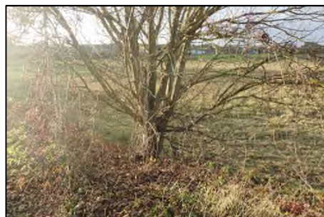
Figure 44 : VTA - Désordre - tronçon 1 : végétation dangereuse (source : Rapport VTA, ISL, 2020)
