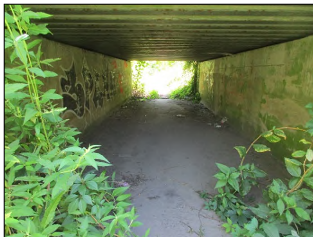
Figure 39 : Tronçon n°3 : côté Oise, passage sous voirie SNCF (source : Artelia)
