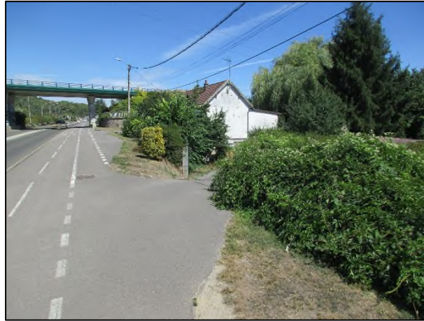
Figure 30 : Tronçon n°1 : vue de l'aval vers le pont amont, talus côté Oise (source : Artelia)
