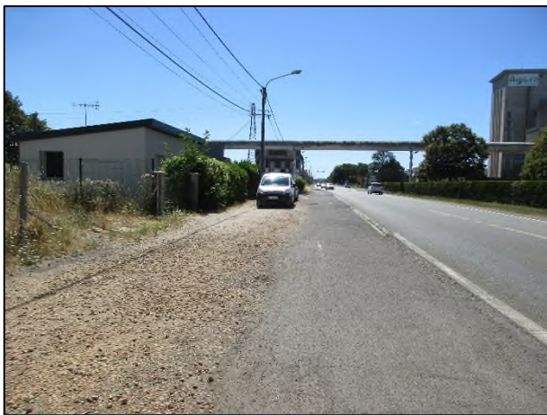
Figure 32 : Tronçon n°2 : bâtiments encastrés côté Oise (source : Artelia)
